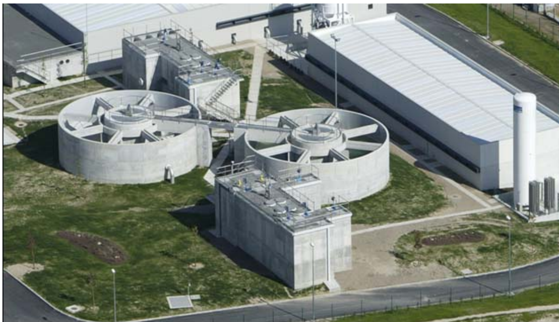
Cámaras de ozonización, previas y posteriores a la decantación. A la derecha: Tanque de O 2
