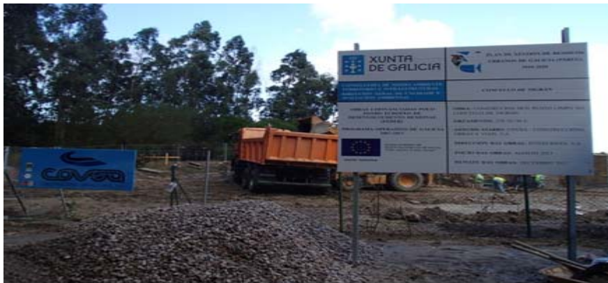
Cartel de obra del punto limpio de Nigrán
